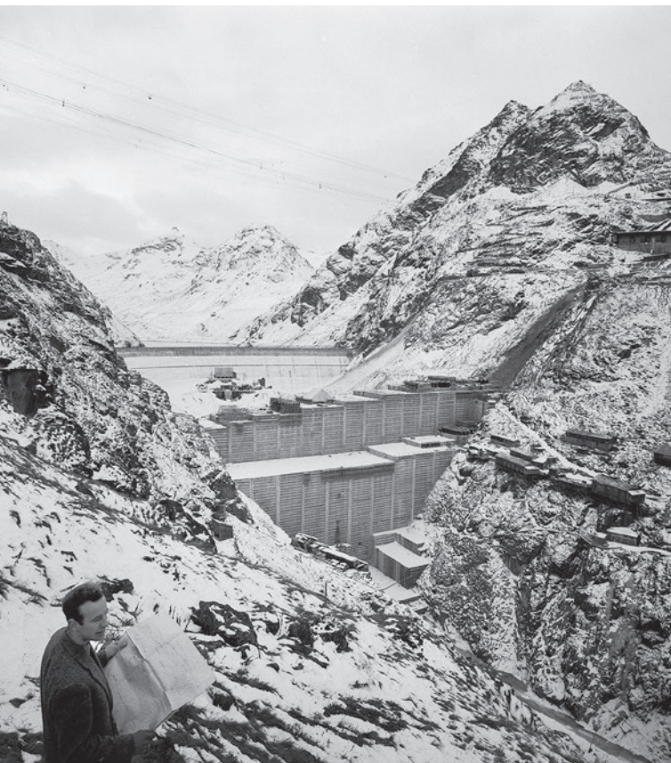
Vue sur la construction du barrage de la Grande Dixence en 1955. À cette date, l'ouvrage avait atteint environ la moitié de sa hauteur finale prévue, qui allait être de 285 m.
